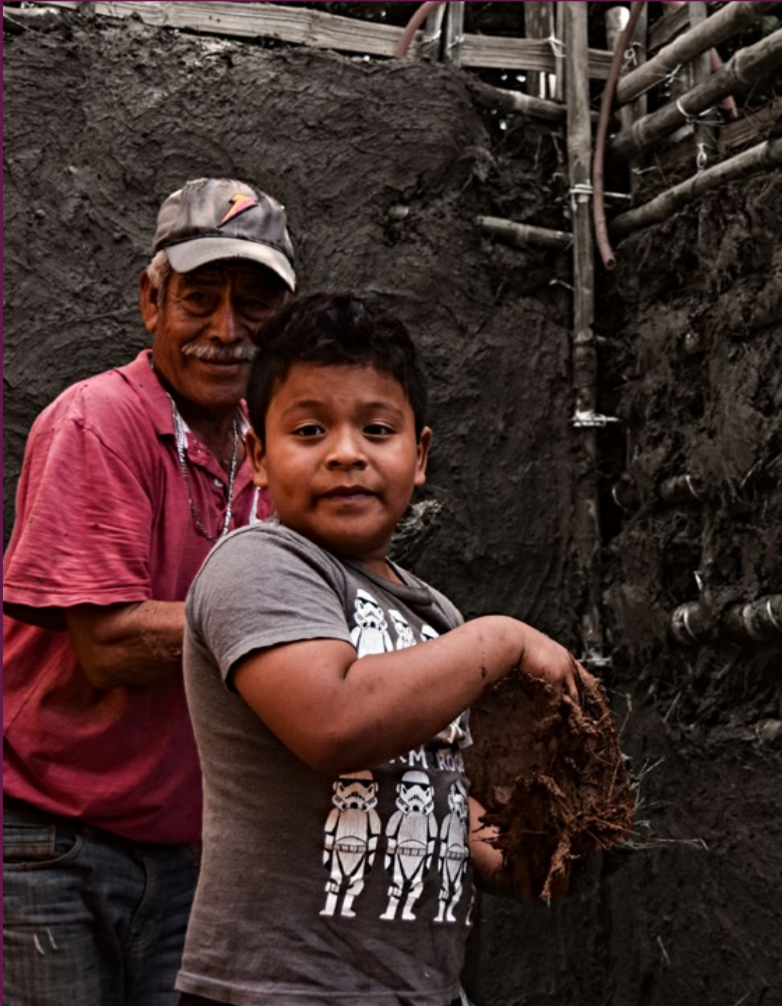
Construcción de vivienda tradicional y transferencia en Ciudad Ixtepec, Oaxaca. Foto de: Cooperación Comunitaria A.C.
